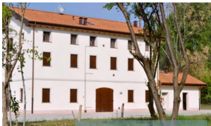
Come si presenta oggi a lavori ultimati
