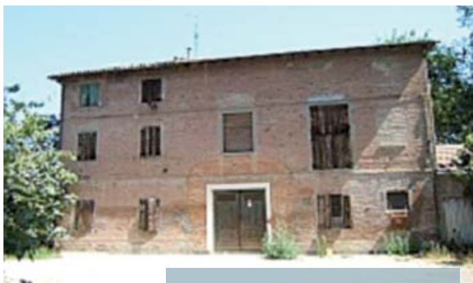
Lo stabile prima dell'intervento
