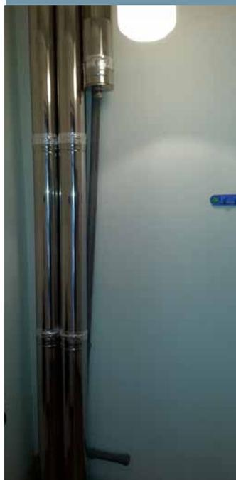
Intervento Via Menotti 181 Rifacimento canne fumarie esterne per sostituzione 4 caldaie Tipo C tradizionali con nuove caldaie a condensazione
